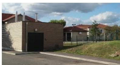
Chaufferie bois à Échalas
