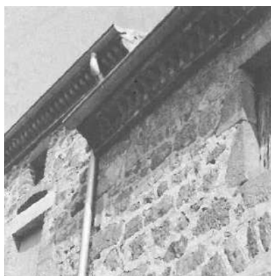
Une toiture avec une corniche en briques ou un porte-à-faux de chevrons pour supporter le dépassé.
