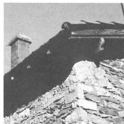
Une toiture avec une corniche en briques ou un porte-à-faux de chevrons pour supporter le dépassé.
