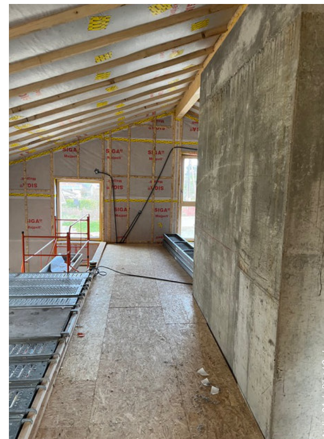
Isolation du bâti
