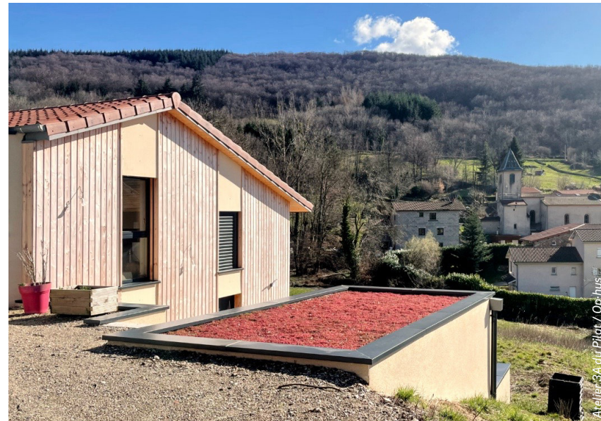
Toiture végétalisée et façade
