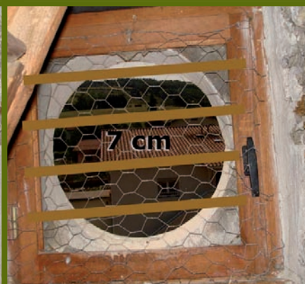
Suppression du grillage et mise en place de barreaux horizontaux
