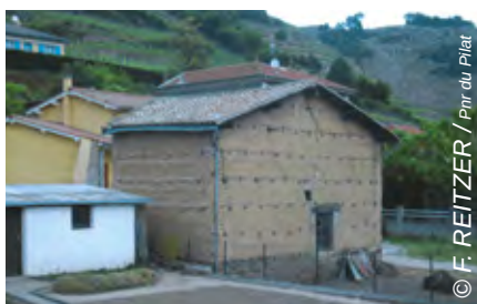
Construction en pisé dans le bourg d'Ampuis
