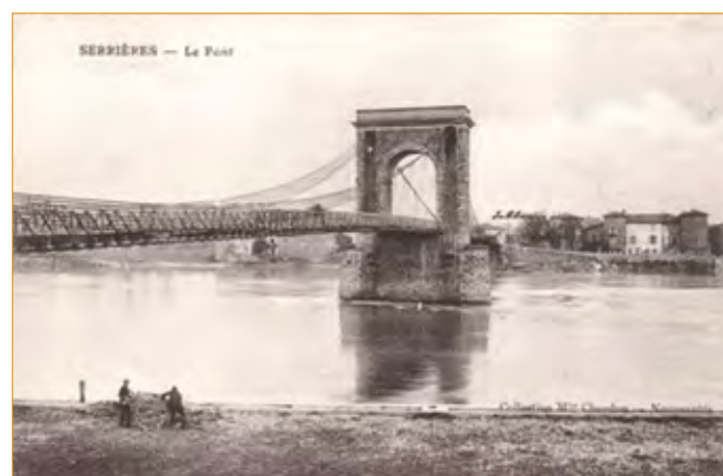
Pont entre Serrières et Sablons de 1828
