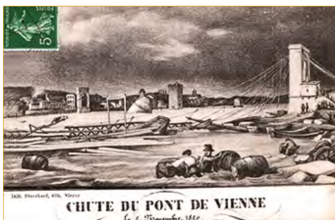
Passerelle piétonne entre Sainte-Colombe et Vienne
