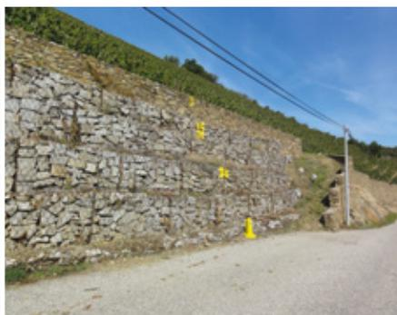
Dispositif de soutènement en pierre de pays (mur ou gabion)
