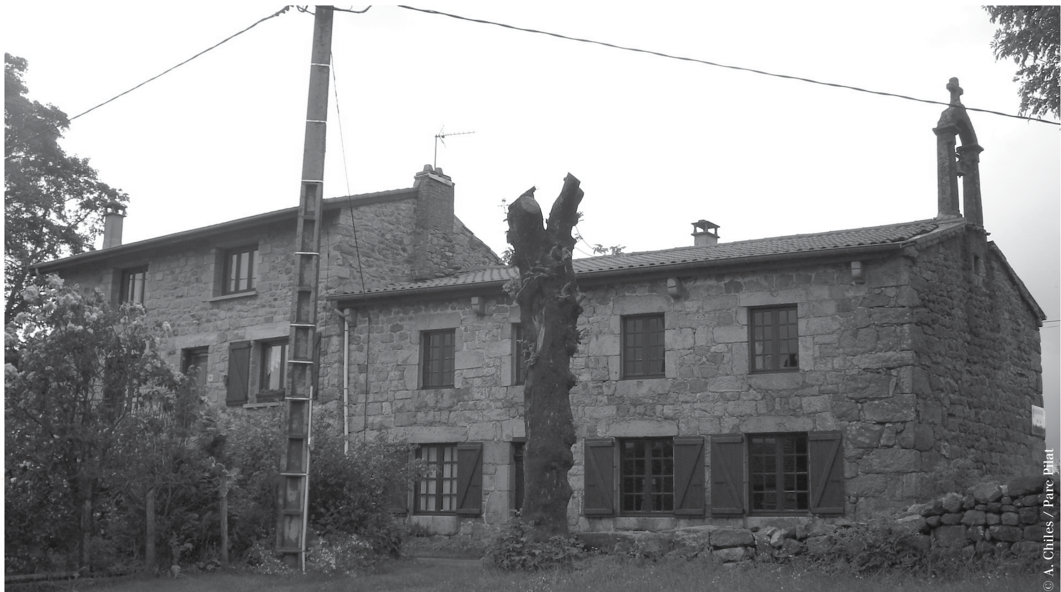
Maison de la Béate de l'Allier, à Marlhes, où résidait Soeur Adélaïde
