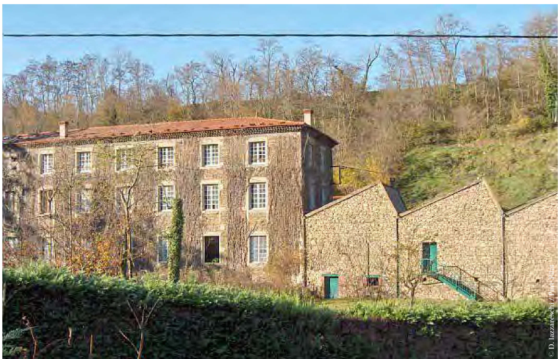
Maison des tresses et lacets, La Terrasse-sur-Dorlay
