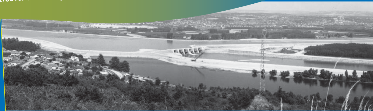
Le chantier du barrage, un paysage lunaire
