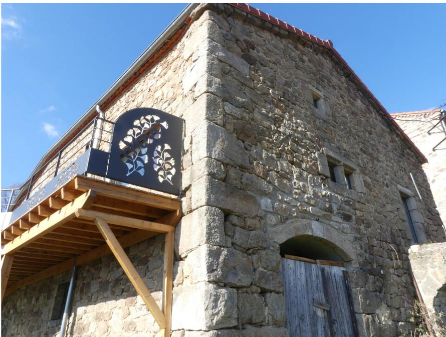
Pour la terrasse extérieure plein sud, le charpentier a utilisé des mélèzes de notre propriété, coupés dans ce but, et façonnés à la scierie du Bessat. Le garde-corps est en métal finition acier, avec un motif personnalisé, de même coloris que les fenêtres. Il a été réalisé par un métallier d'art de Burdigues.
