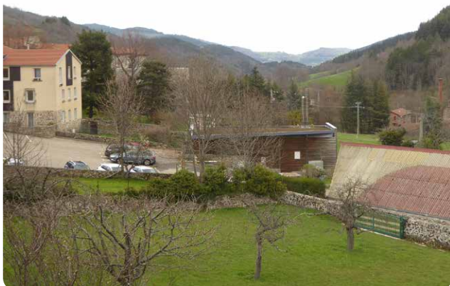
Cône de vue sur la vallée de la Déôme maintenu dégagé par la toiture plate de la chaufferie bois de St Sauveur-en-Rue
