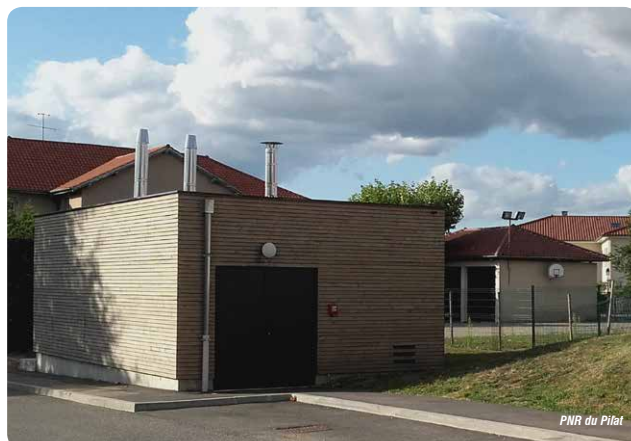
Chaufferie bois à Pélussin
