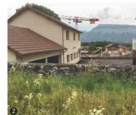
Mur existant accompagné par une haie bocagère au niveau des talus
