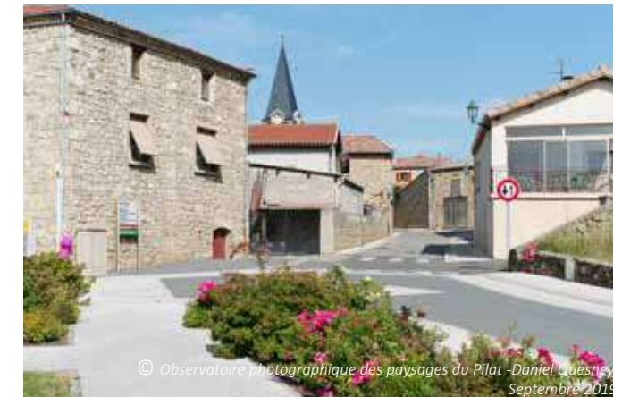
Mise à distance du piéton de la voirie par un trottoir et une bande de végétation basse et différenciation des matériaux au sols - Bessey
