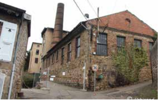
Ancien bâtiment industriel au coeur de la centralité de Saint-Julien Molin Molette.
