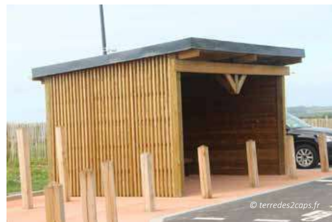
Un abri vélo/zone d'attente Aire de covoiturage du Mont de Cappe - Marquise
