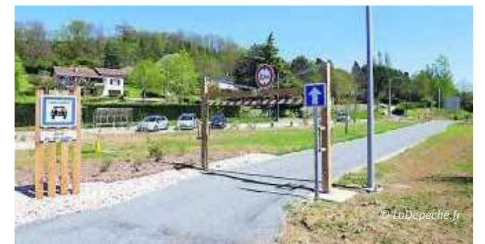
Traitement paysager et traversées piétonnes Aire de covoiturage du Drazou - Occitanie
