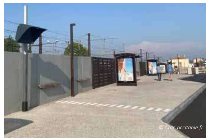
Abri bus, banc et signalisation au sol marquant les différents quais - Gare de Lunel - Occitanie
