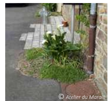
Pieds de mur végétalisés. Epinac (35)
