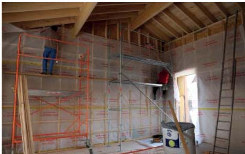
Pour parfaire l'isolation et limiter les infiltrations d'air, un pare-vapeur est disposé sur l'ossature en bois.
