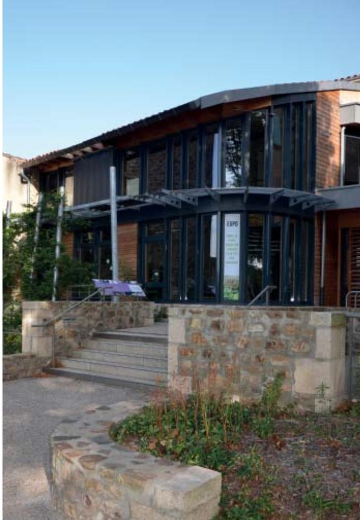
Tout en ayant conservé bien visibles les murs en pierre du moulinage et en reconduisant une toiture en tuiles, de nouveaux matériaux ont été introduits : le vitrage, la toiture végétalisée **12**, l'ossature et le bardage en bois ainsi que la structure métallique grise des poteaux et des brise-soleils **11**.
