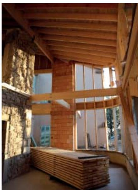
Agrandissement avant installation du plancher structurant
