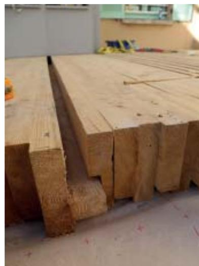
Plancher structurant : Les planches sont clouées champ contre champ pour améliorer la portance du plancher et ainsi éviter le rajout de poutre porteuse.
