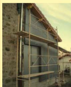
Réhabilitier suivant les normes thermiques à venir
