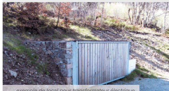
exemple de local pour transformateur électrique
