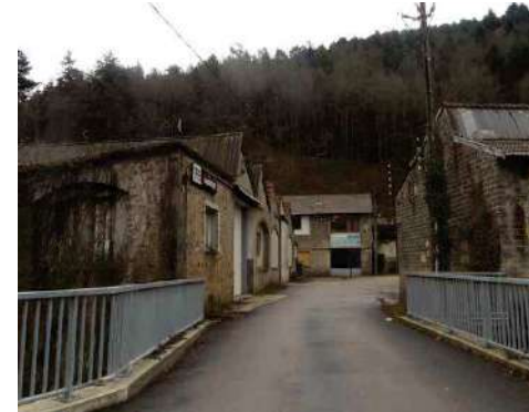
Friche économique en cours de réhabilitation - Bourg-Argental
