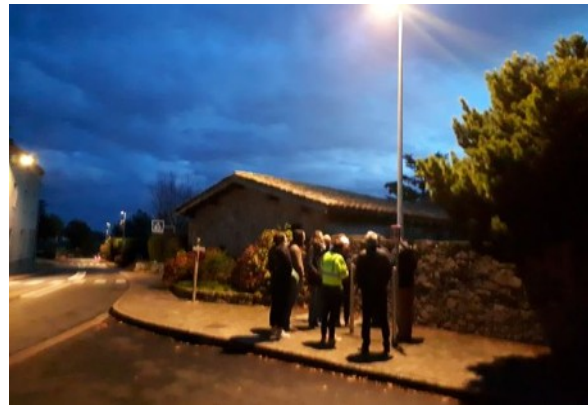
Lampadaire équipé de détecteur à l'entrée d'un lotissement
