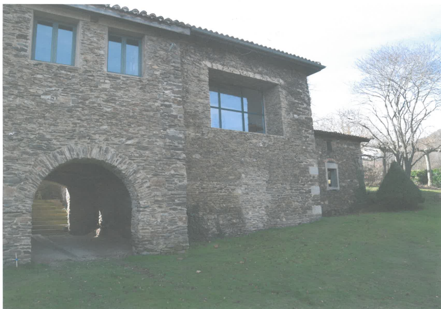
Façade Nord. Allée reliant la cour intérieure. Ce mur a été démolé puis reconstruit avec les pierres de toutes les démolitions. A côté une grande baie vitrée a été percée en double vitrage.
