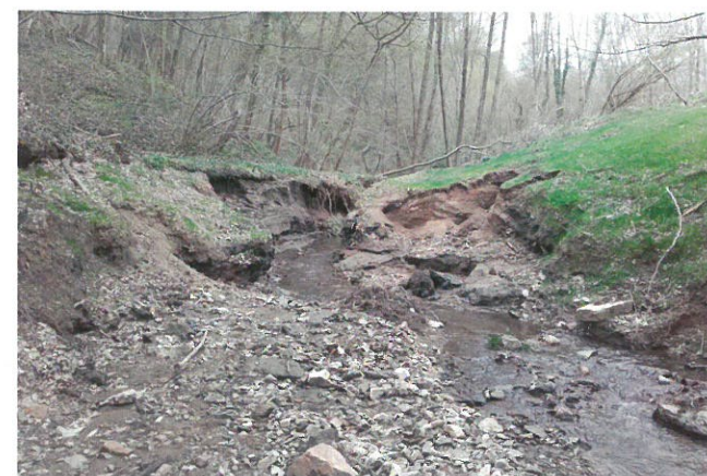
Suppression d'un seuil sur le ruisseau des Haies (réalisation du premier CVB)
